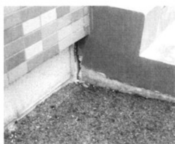
基礎周辺廊下の土台破損・ひびわれ
