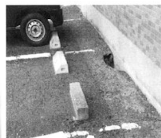
駐車場舗装面の陥没
