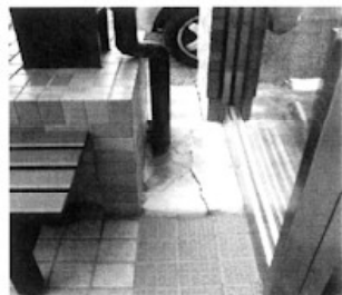
玄関口のタイル破損・ひびわれ・コンクリートの割れ
