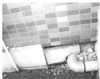
基礎周辺廊下の土台破損・ひびわれ
